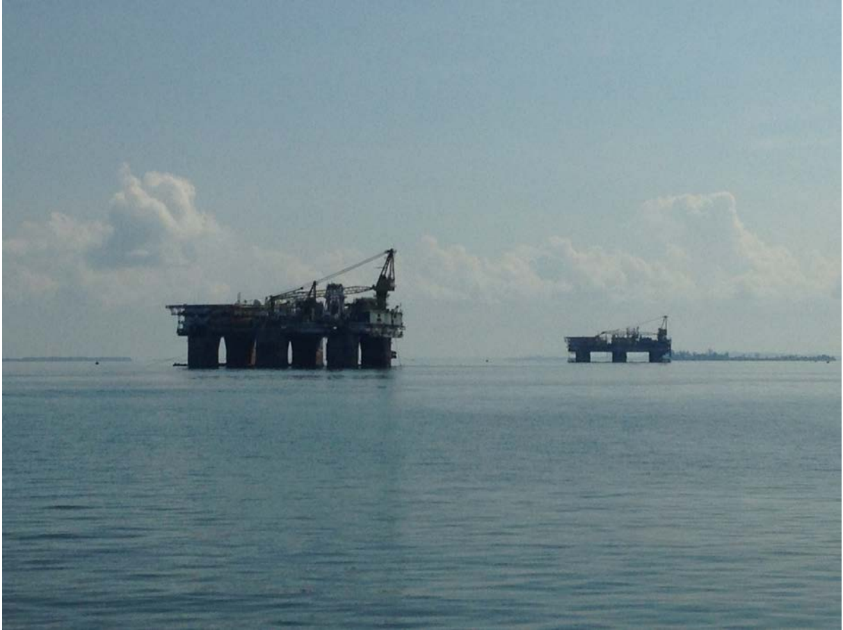
Offshore-Plattformen bei Pulau Bintan, Indonesien (Quelle: Breul 2016)
